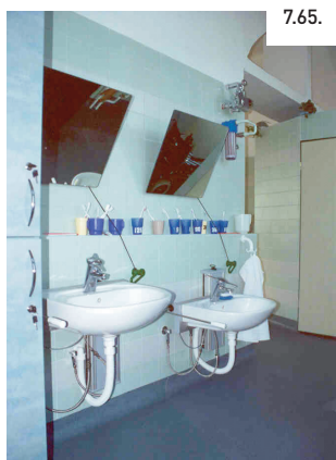
7.65. ÁBRA A Mexikói úti Mozgásjavító Iskola állítható magasságú mosdói, egykaros csaptelepei és dönthető tükröi
