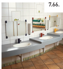
7.66. ÁBRA Lépcsősen emelkedő pultba beépített mosdók egy óvodában, a különböző használói magasságok kielégítésére
